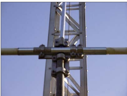
Bild 5: Befestigung der beiden Boomrohre; die Abspannung ist mittels 40-mm-Aluminiumrohr und 6-mm-Stahlseil realisiert.
