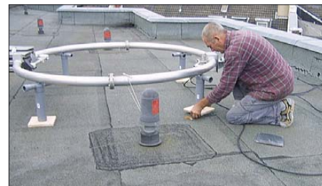
Bild 2: Liegende Montage der Magnetschleifenantenne Fotos: DL2KDK
