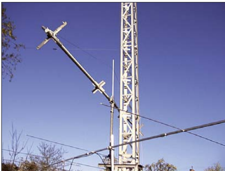
Bild 4: Für die 20-m-Elemente wurden große Haltekreuze genutzt.
